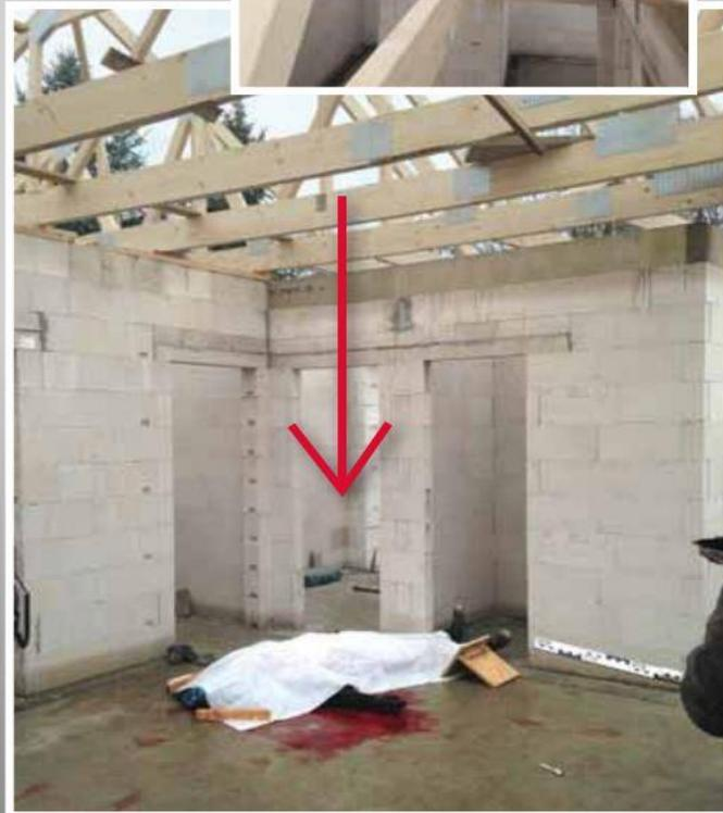
Beim Begehen der 8,0 Zentimeter breiten Binder rutschte der Maurer ab und stürzte 3,25 Meter tief auf den Betonboden des Hauses.
