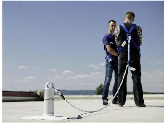
Künstliche Ankerpunkte sind industriell explizit für die Verwendung als Ankerpunkte und Anschlagmittel hergestellte Elemente, die in der EN 795 näher beschrieben sind. Diese werden am Einsatzort entsprechend der Norm und der Herstellervorgaben montiert und verwendet.
