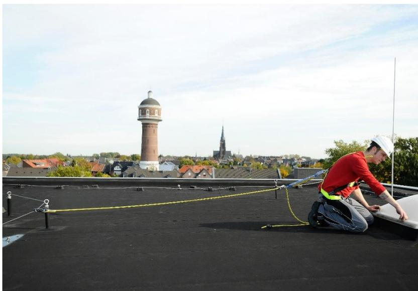
**Bei diagonalen Seilverläufen sind seitliche Absturzgefahren, mit Pendelstürzen und scharfen Kanten zu berücksichtigen!**
