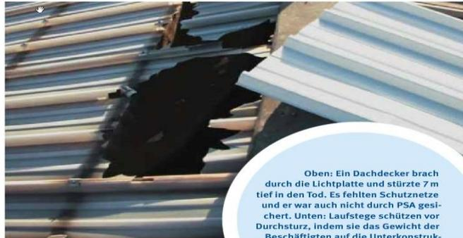
Oben: Ein Dachdecker brach durch die Lichtplatte und stürzte 7 m tief in den Tod. Es fehlten Schutzzetze und er war auch nicht durch PSA gesichert. Unten: Laufstege schützen vor Durchsturz, indem sie das Gewicht der Beschäftigten auf die Unterkonstruktion des Daches verteilen. Darunter gespannte Netze verhindern den Absturz.
