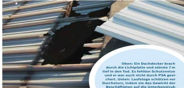
Oben: Ein Dachdecker brach durch die Lichtplatte und stürzte 7 m tief in den Tod. Es fehlten Schutznetze und er war auch nicht durch PSA gesichert. Unten: Laufstege schützen vor Durchsturz, indem sie das Gewicht der Beschäftigten auf die Unterkonstruktion des Daches verteilen. Darunter gespannte Netze verhindern den Absturz.
