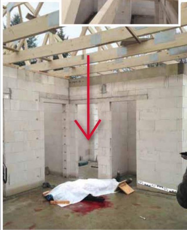
Beim Begehen der 8,0 Zentimeter breiten Binder rutschte der Maurer ab und stürzte 3,25 Meter tief auf den Betonboden des Hauses.
